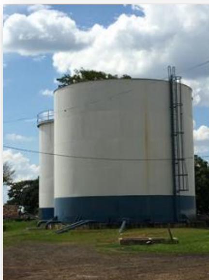
Figura 116 - Vista dos reservatórios R02 e R03
