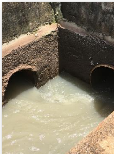
Figura 213 - Canal de chegada.
