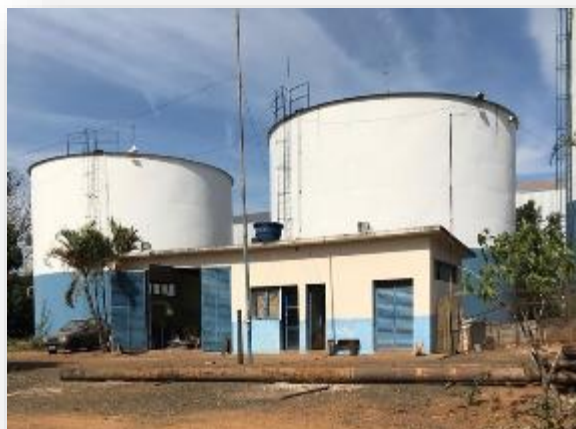
Figura 156 - Vista dos reservatórios R11 e R12
