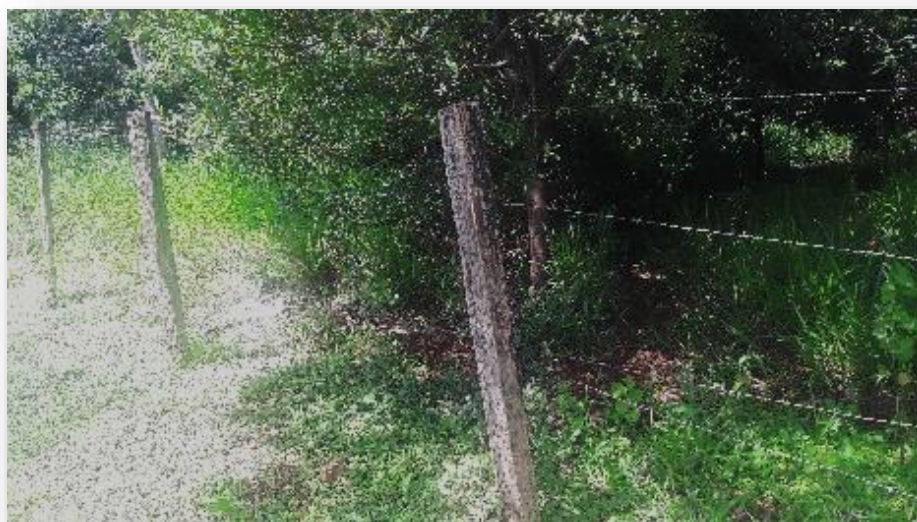
Figura 234 – Cercamento da ETE Divisa.
