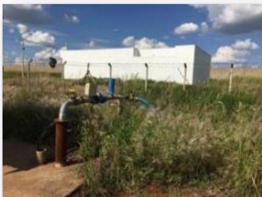
Figura 102 - Vista geral do poço.
