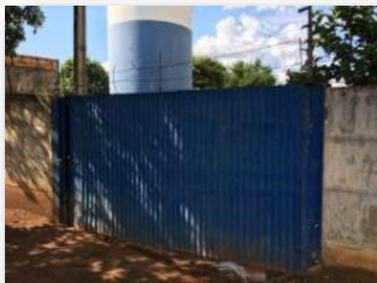
Figura 152 - Portão de entrada R10.
