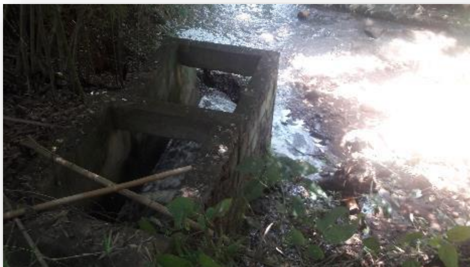
Figura 233 - Lançamento da ETE Divisa.
