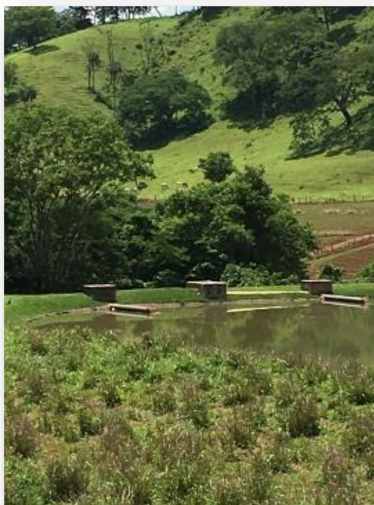
Figura 222 - Entrada na Lagoa facultativa.
