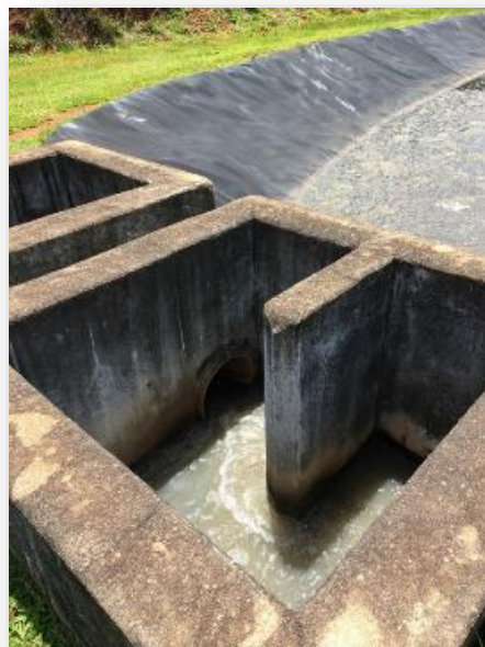
Figura 217 - Saída do tratamento preliminar.
