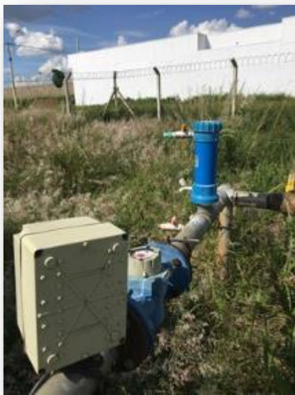
Figura 103 - Vista geral do poço.
