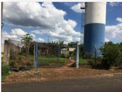
Figura 135 - Portão do reservatório R08.
