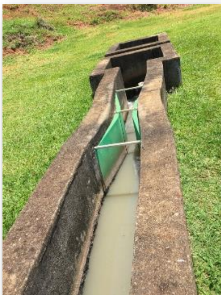
Figura 215 - Calha Parshall.
