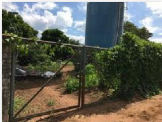
Figura 125 - Entrada do reservatório R07.
