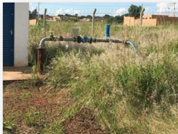
Figura 101 - Vista geral do poço.
