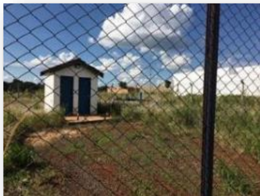
Figura 98 - Vista do poço desde o exterior.
