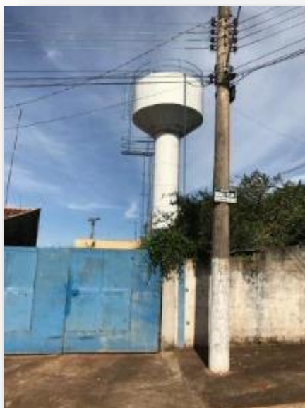
Figura 123 - Vista do reservatório R06
