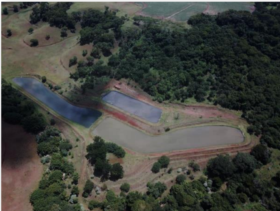
Figura 208 - Vista geral da ETE Divisa.
