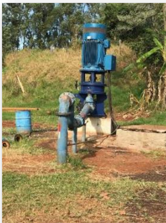
Figura 44 – Poço Contendas (I)
