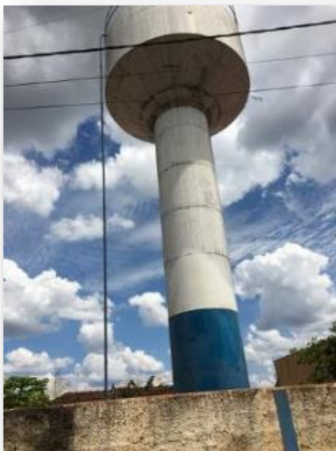
Figura 124 - Vista do reservatório R06
