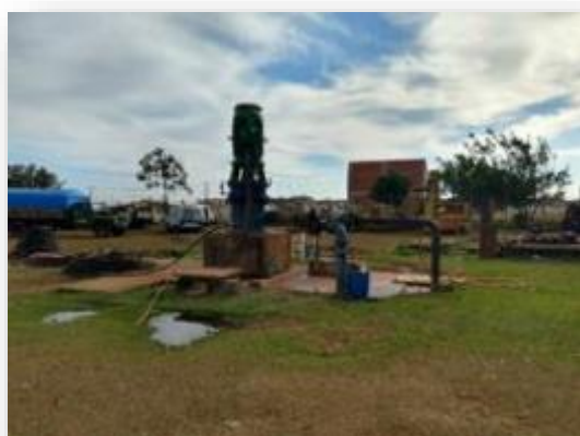
Figura 77 - Vista geral Poço Casa Branca.
