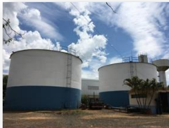
Figura 157 - Vista dos reservatórios R11 e R12
