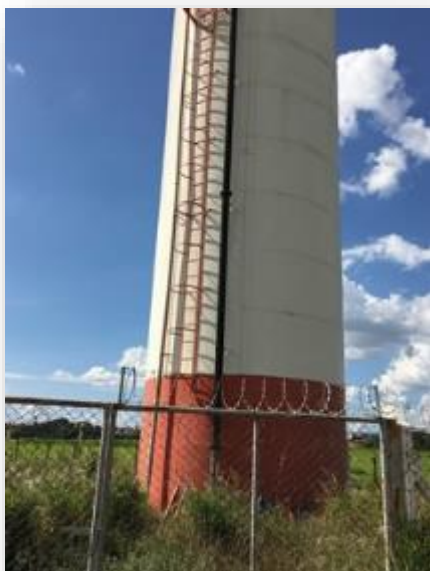
Figura 166 - Vista do reservatório R14 Fortaleza.
