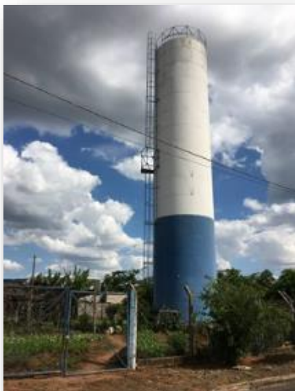
Figura 134 - Vista do reservatório R08.
