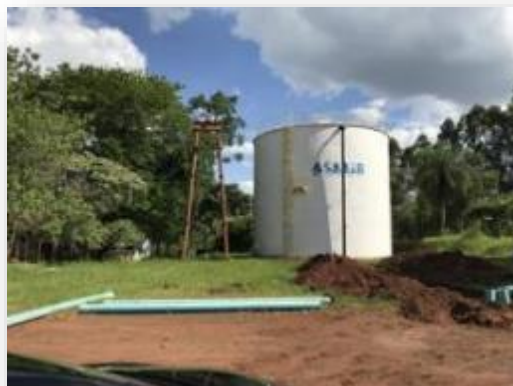
Figura 110 - Vista geral do reservatório
