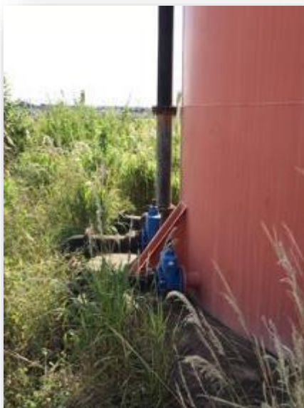
Figura 169 - Lateral do reservatório com tubulações.
