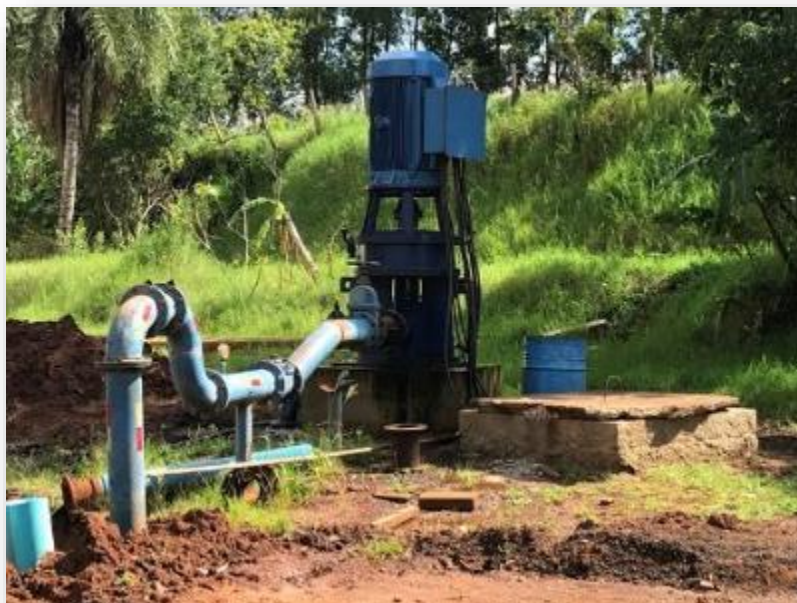
Figura 45 – Poço Contendas I
