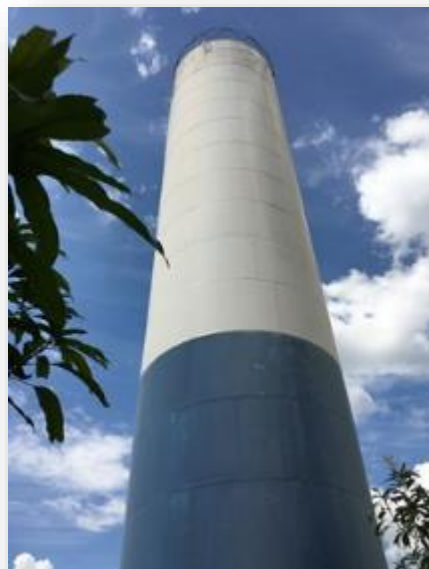
Figura 136 - Vista do reservatório R08.
