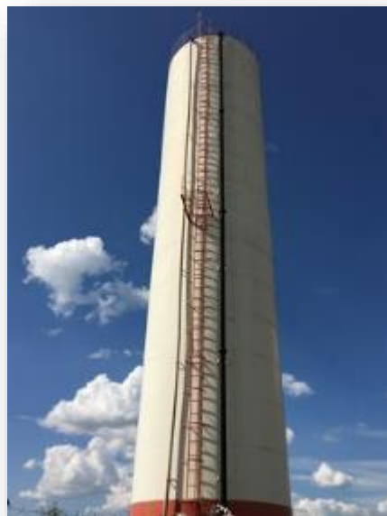
Figura 167 - Vista do reservatório R14 Fortaleza.
