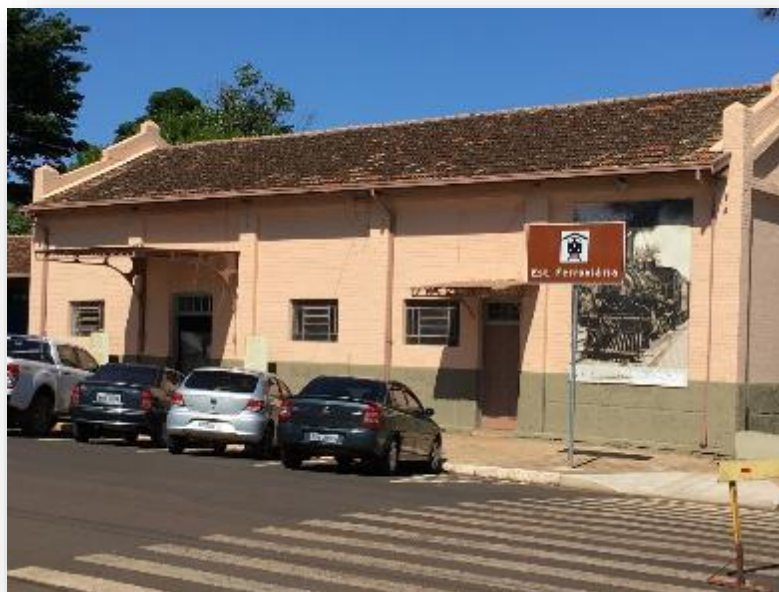
Figura 7 – Estação Ferroviária de Brodowski
