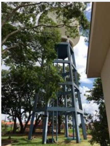
Figura 119 - Vista do reservatório R05.
