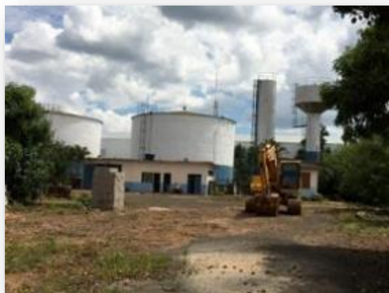
Figura 155 - Vista geral do local.
