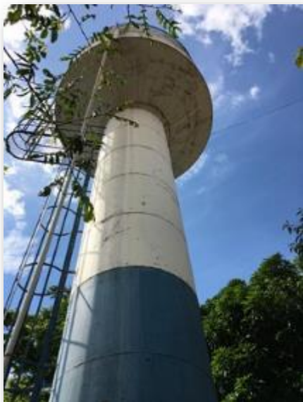
Figura 144 - Vista do reservatório R09.
