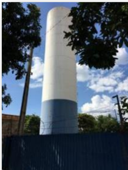
Figura 153 - Vista reservatório R10.
