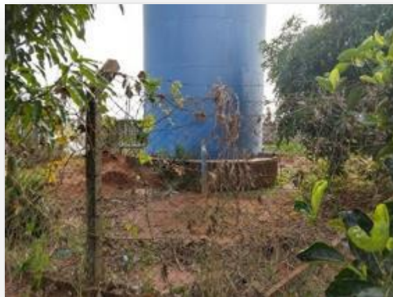
Figura 137 - Vista do Reservatório R08.
