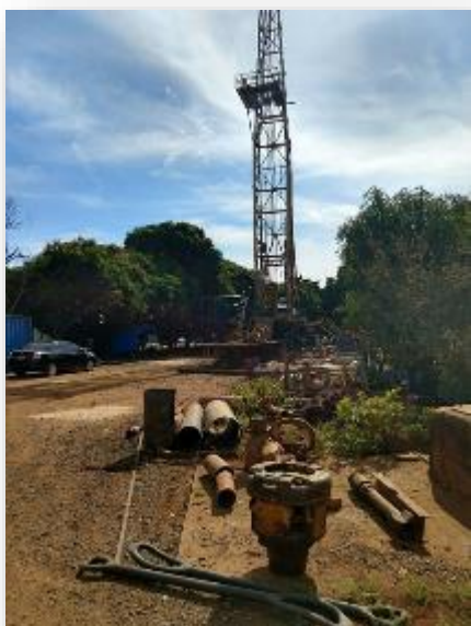
Figura 89 - Vista do poço em perfuração
