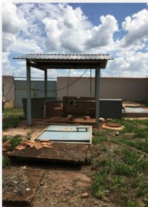
Figura 191 - Vista geral da EEE Verona.
