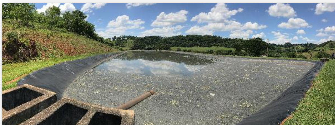
Figura 220 - Vista Geral da Lagoa anaeróbia.
