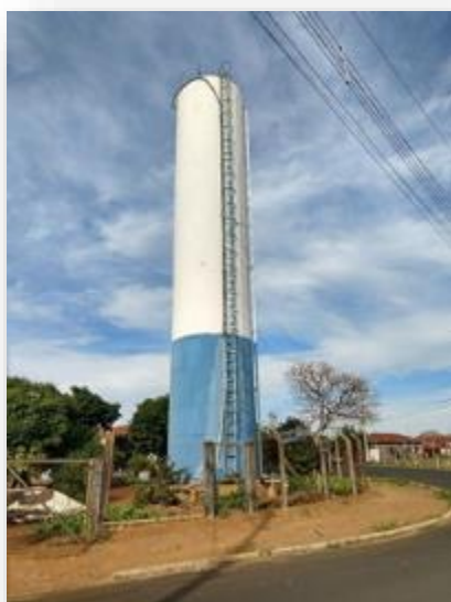
Figura 126 - Vista do reservatório R07
