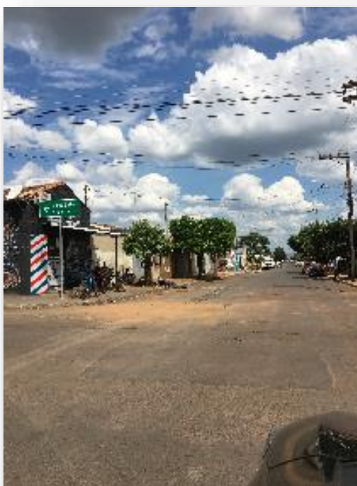
Figura 171 - Valas da troca de redes.
