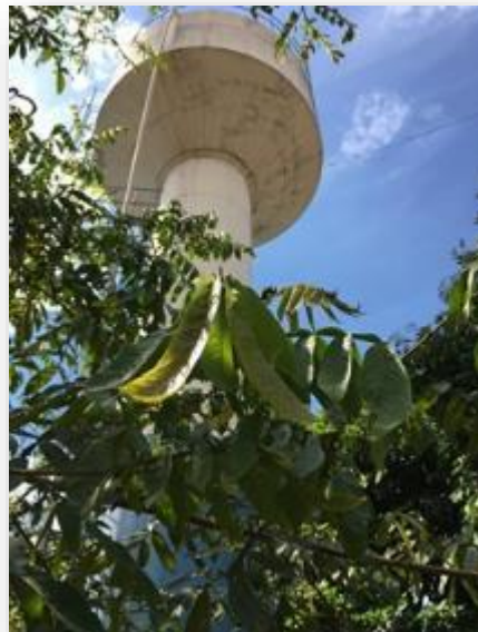
Figura 145 - Vista do reservatório R09.
