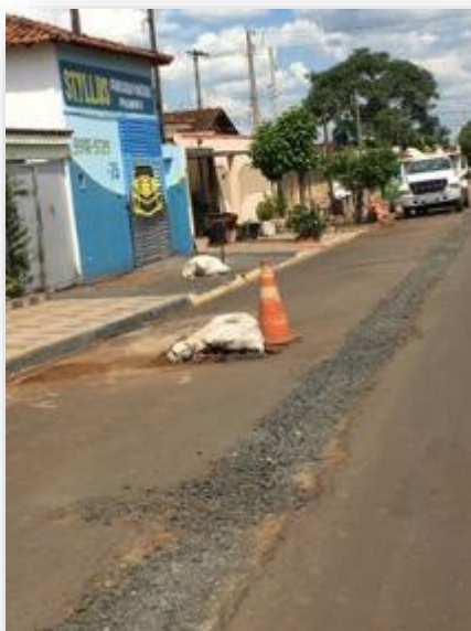
Figura 172 - Valas da troca de redes.
