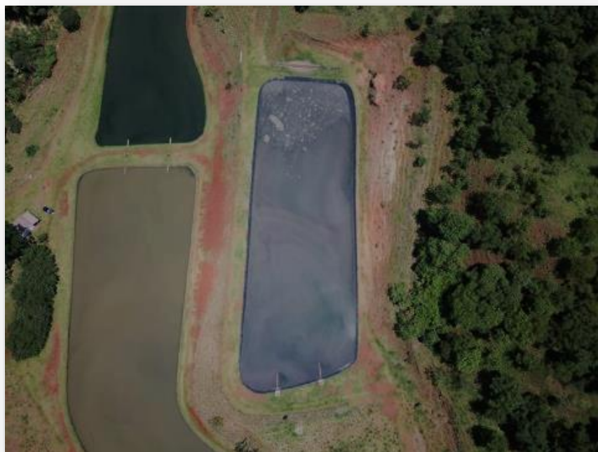
Figura 209 - Detalhe da lagoa anaeróbia.
