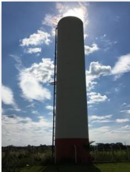
Figura 165 - Vista do reservatório R14 Fortaleza.
