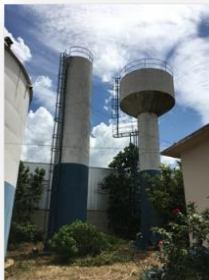
Figura 158 - Vista dos reservatórios desativados.
