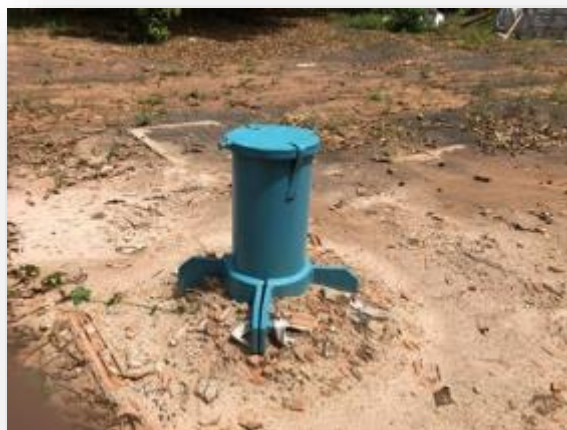
Figura 90 - Vista do poço perfurado
