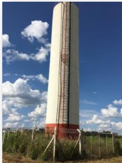
Figura 168 - Vista do reservatório R14 Fortaleza.
