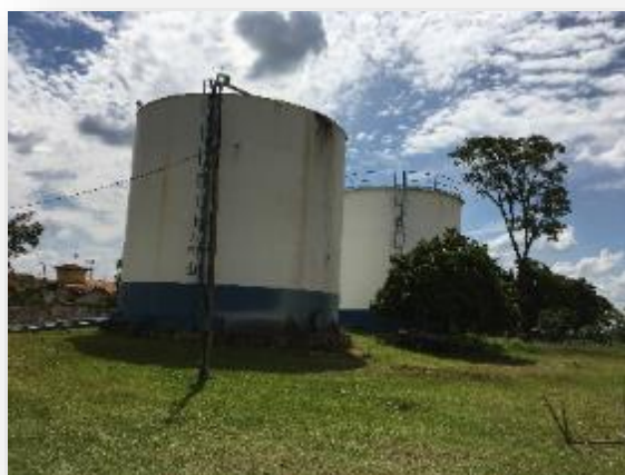
Figura 115 - Vista dos reservatórios R02 e R03
