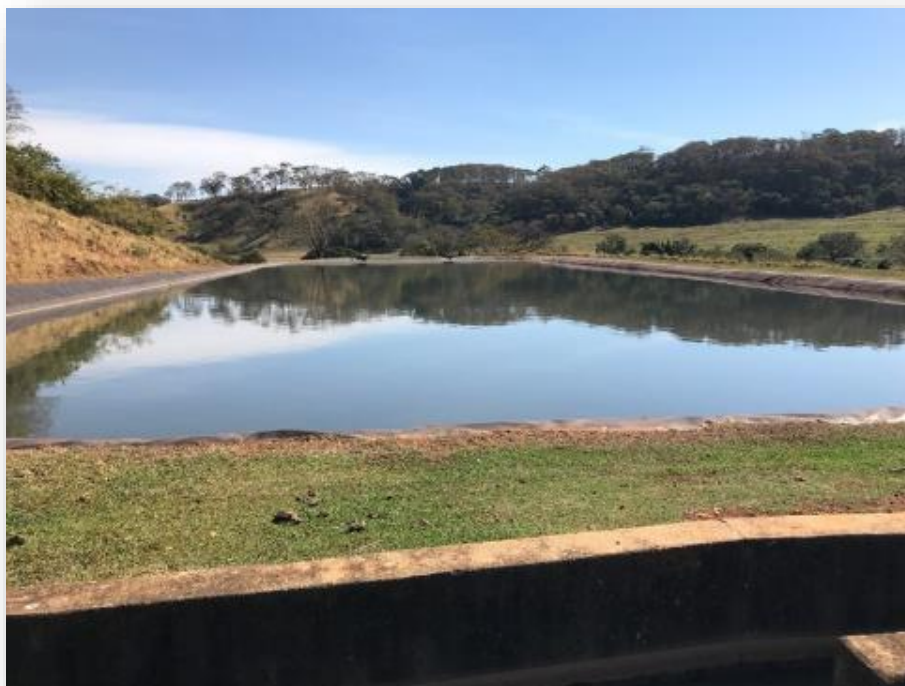
Figura 219 - Vista Geral da Lagoa anaeróbia.
