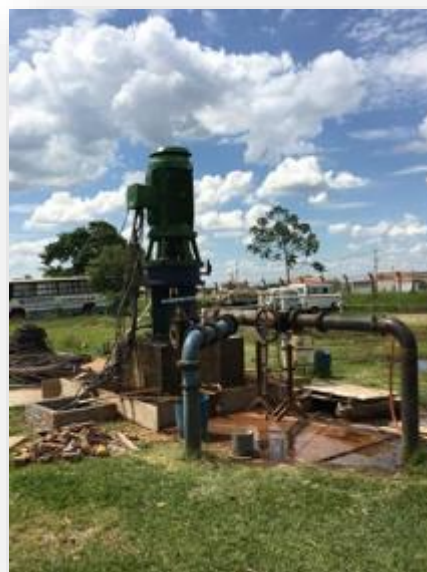
Figura 79 - Vista geral Poço Casa Branca.
