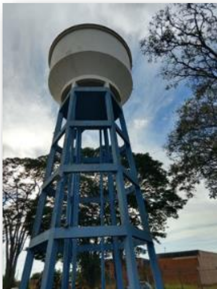
Figura 120 - Vista do reservatório R05.
