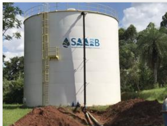
Figura 112 - Reservatório 2000 m 3 .
