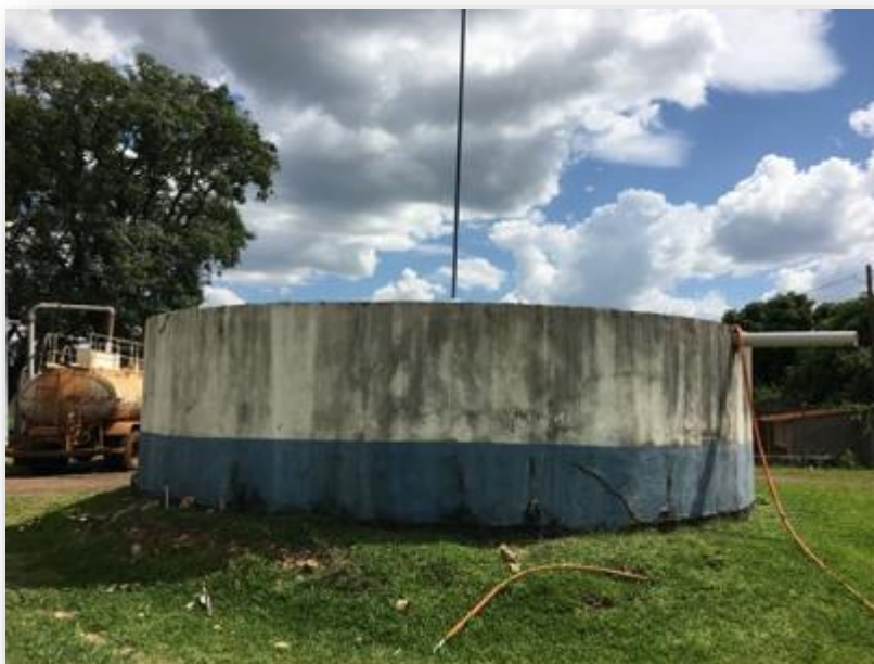
Figura 118 - Vista do Reservatório R04.
