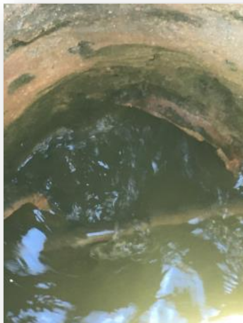
Figura 230 - Saída da Lagoa de maturação.
