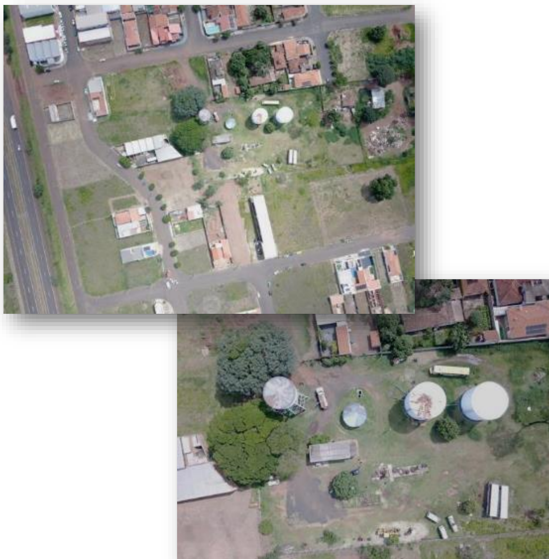
Figura 75 - Vista Geral Casa Branca.
