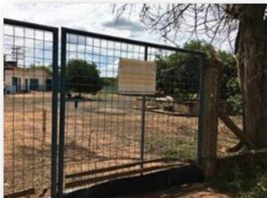
Figura 88 - Entrada à área do poço Distrito Industrial.
