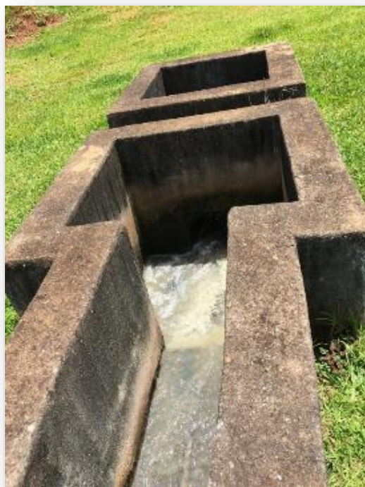
Figura 216 - Saída do Tratamento Preliminar.
