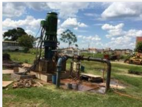
Figura 78 - Vista geral Poço Casa Branca.
