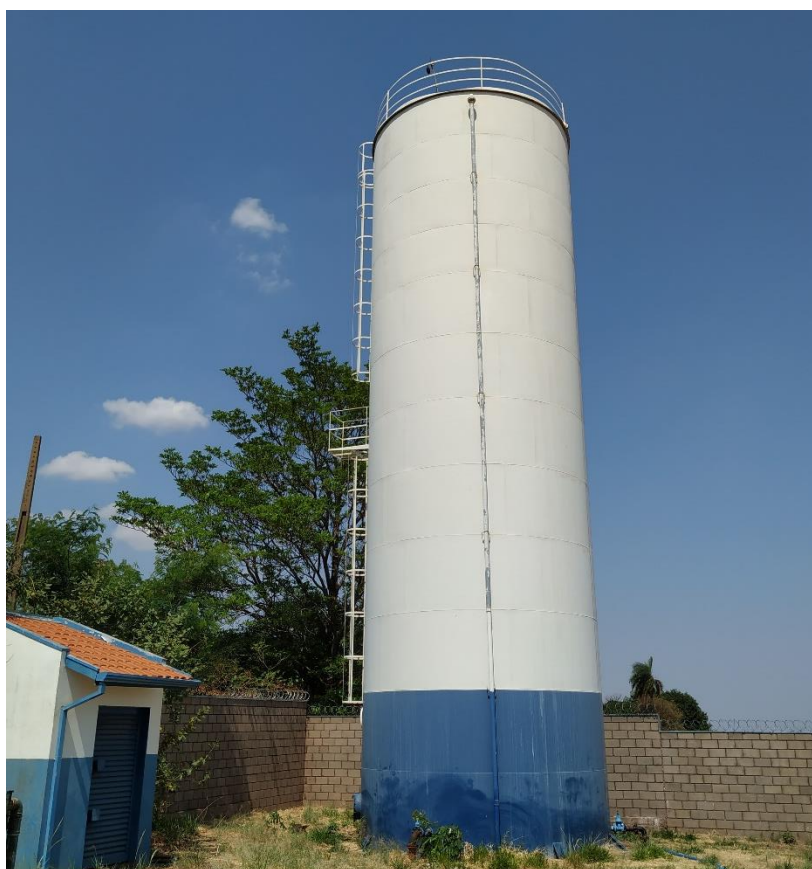
Foto 18: Vista do reservatório Quebec
