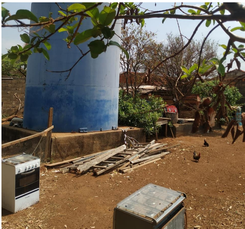
Foto 27: Base do reservatório Girardi. Há eletrodomésticos e galinhas no local
