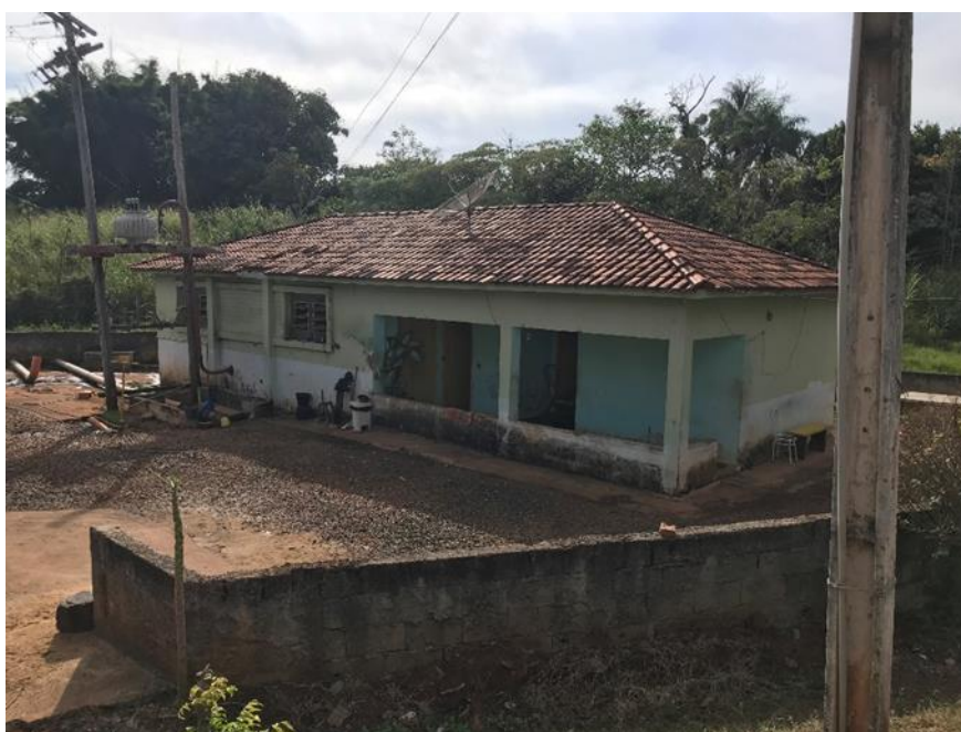
Foto 4: Vista da casa de abrigo dos sistemas de recalque
