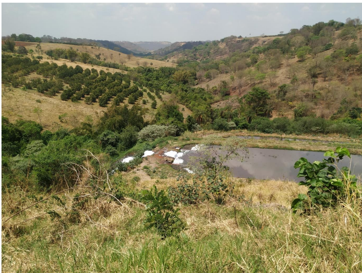
Foto 37: Vista da porção final da lagoa de maturação. A formação de espuma espessa indica provável contaminação de água residuária industrial
