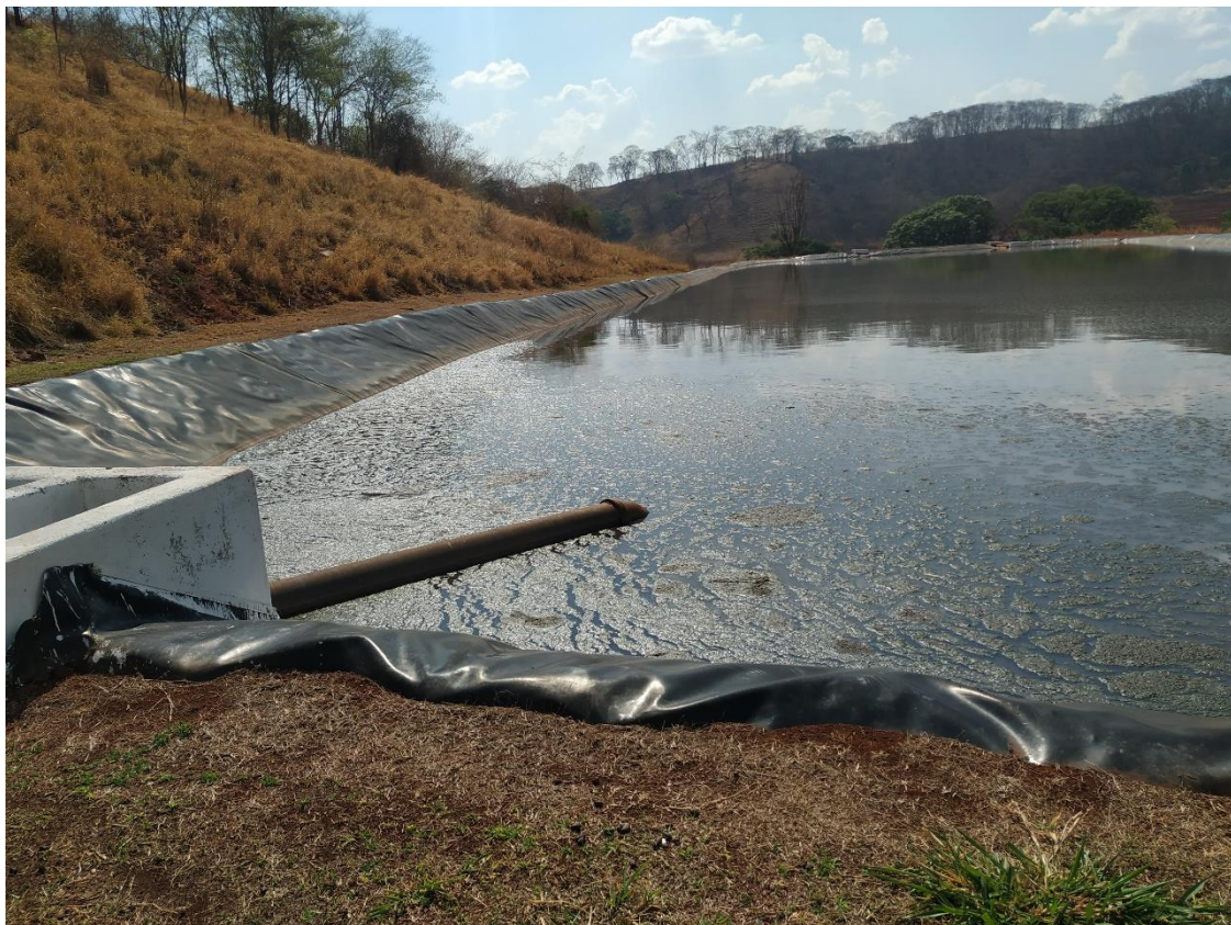
Foto 40: Vista da lagoa anaeróbia na ETE Divisa
