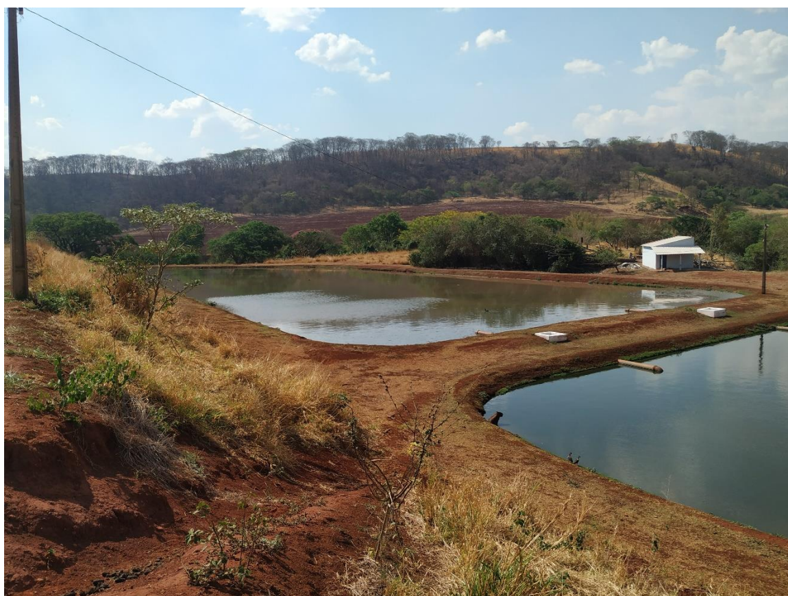
Foto 41: Vista da lagoa facultativa (acima) e de maturação (abaixo) na ETE Divisa
