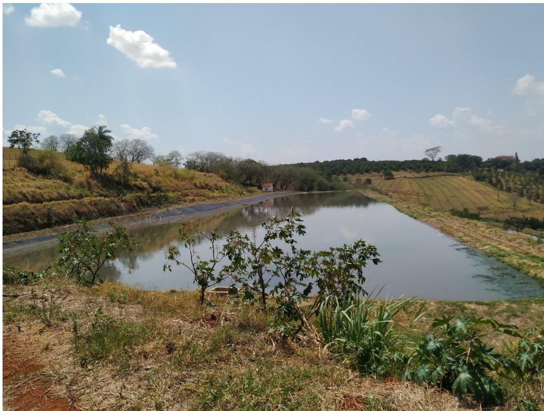
Foto 35: Vista da lagoa facultativa
