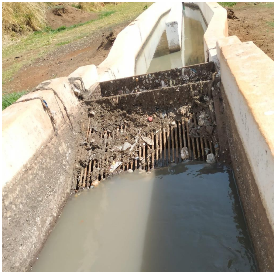
Foto 39: Detalhe da grade para remoção de sólidos grosseiros
