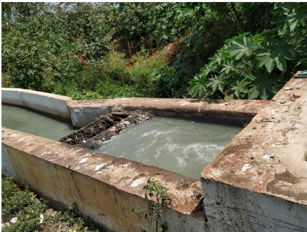
Foto 31: Chegada do esgoto na ETE Prata
