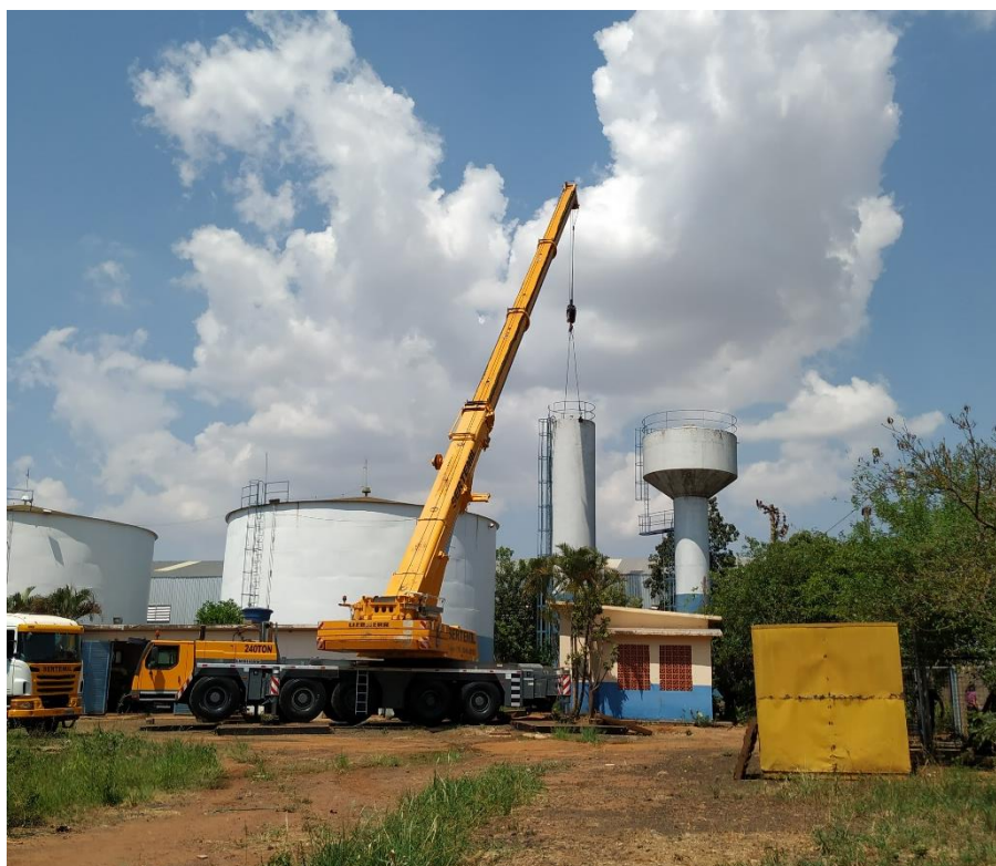
Foto 12: Vista dos reservatórios apoiado e elevado no CPR Distrito Industrial
