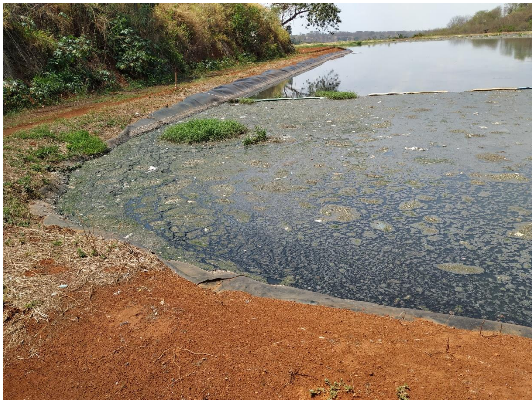
Foto 33: Acúmulo escuma na porção inicial da lagoa anaeróbia
