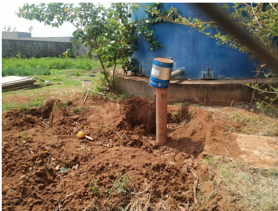
Foto 29: Detalhe da base do reservatório Sítio Brodowski
