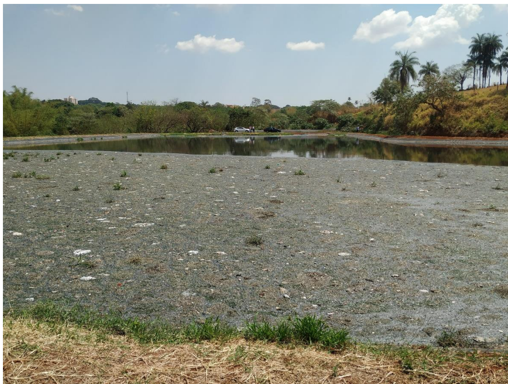
Foto 34: Acúmulo de escuma na porção final da lagoa anaeróbia
