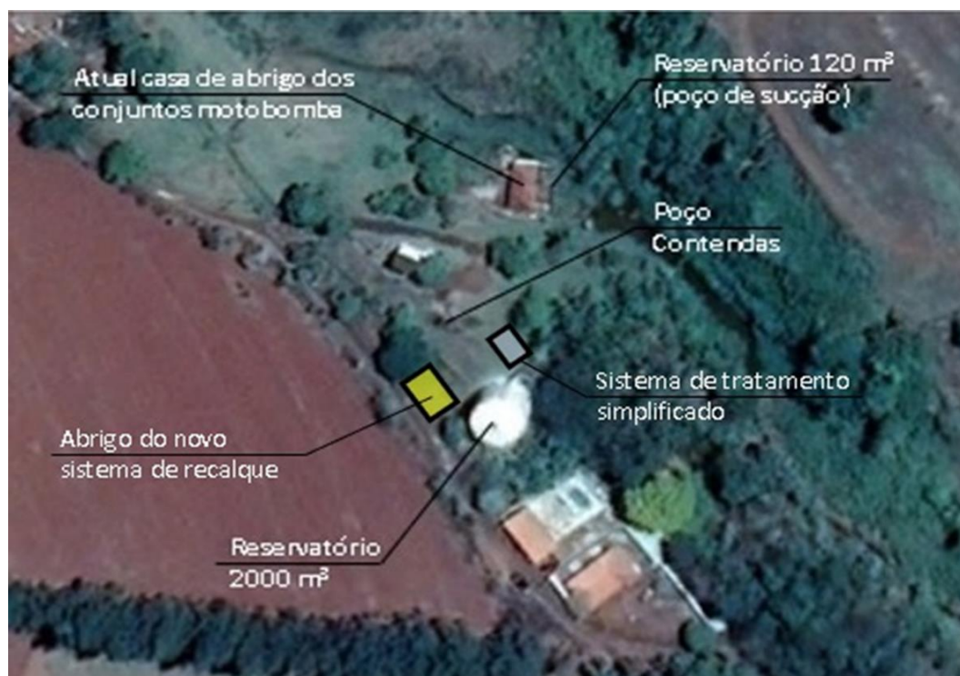
Figura 4.7: Local de implantação do sistema de tratamento simplificado no CPR Contendas
