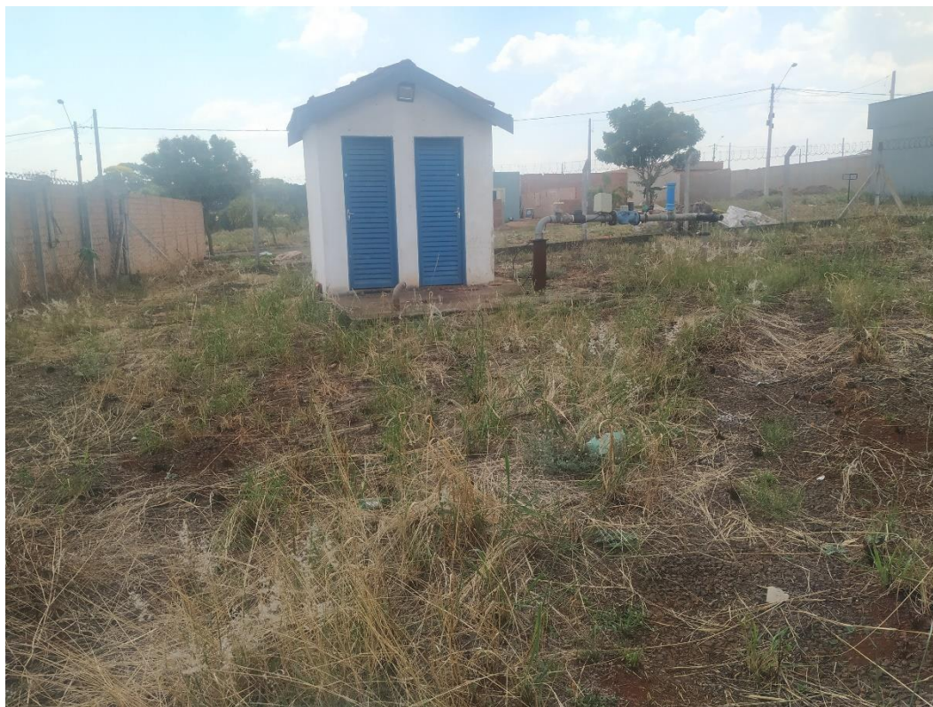
Foto 20: Vista do poço Fortaleza
