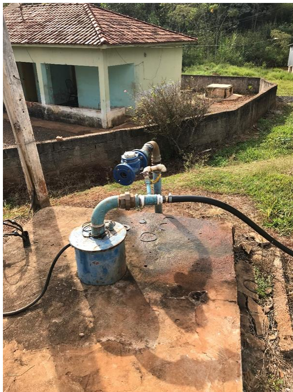
Foto 3: Poço Contendas II (desativado)
