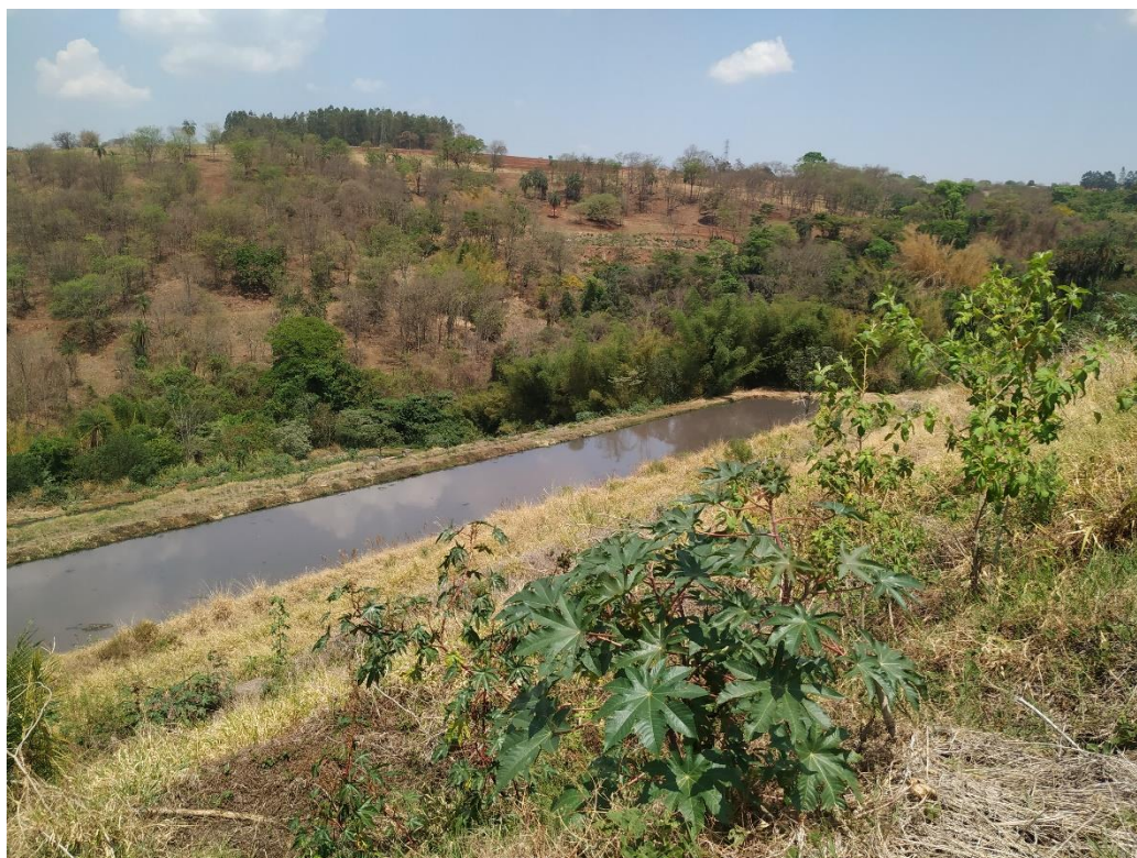
Foto 36: Vista da lagoa de maturação
