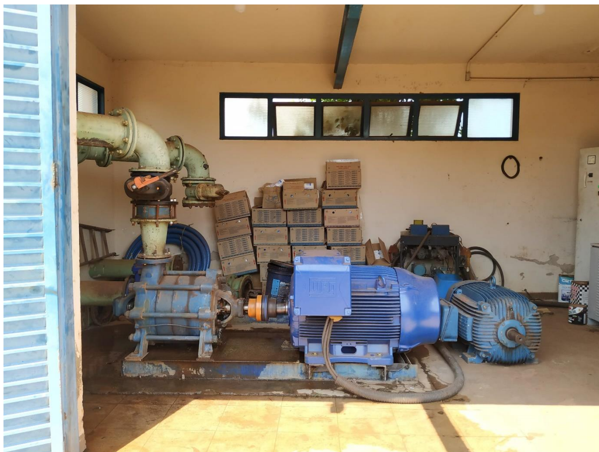
Foto 13: Bomba de recalque no CPR Distrito Industrial
