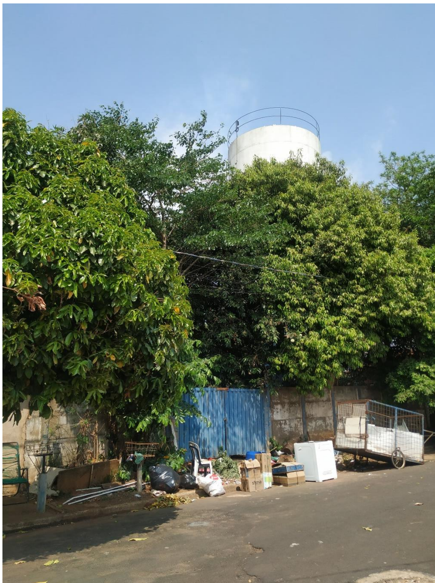
Foto 23: Vista do reservatório Cohab IV
