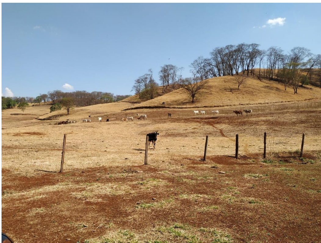
Foto 43: A área da ETE faz divisa com um terreno onde é mantido gado. A cerca estava quebrada e os animais tinham acesso à área da ETE
