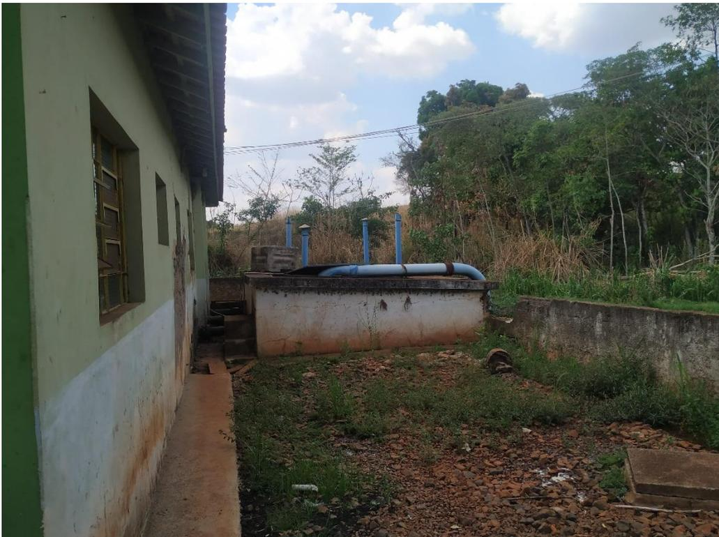
Foto 2: Vista do reservatório atualmente alimentado pelo poço e que serve como poço de sucção para os conjuntos motobomba
