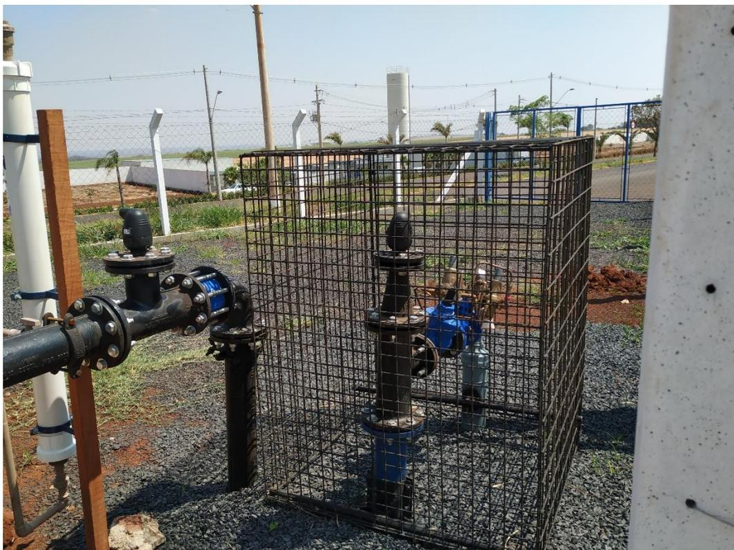
Foto 16: Golpe de aríete instalado junto ao poço Jardim Miranda
