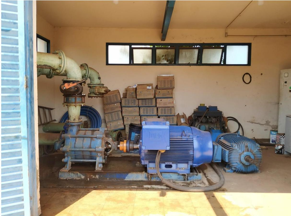
Foto 13: Bomba de recalque no CPR Distrito Industrial
