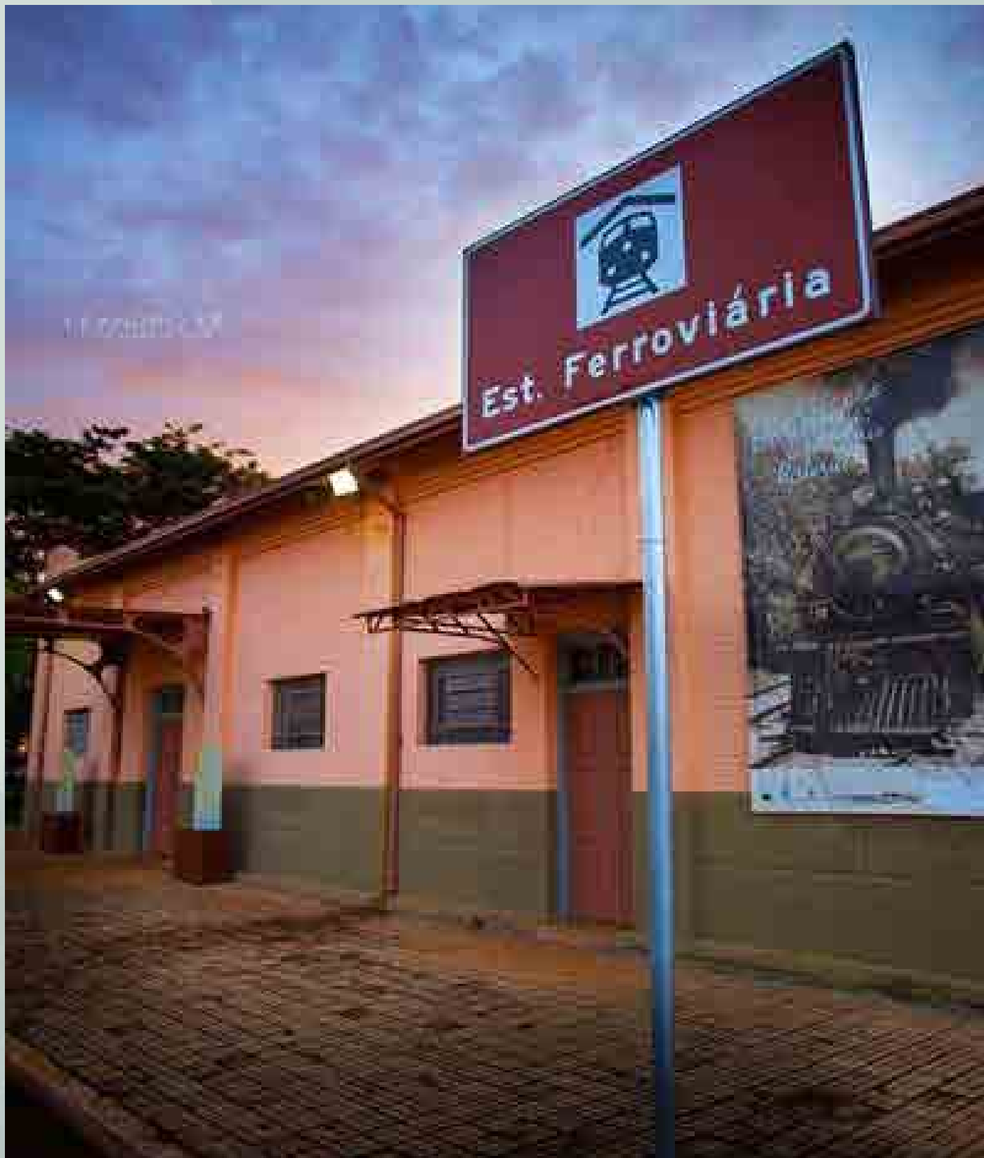
Figura 30: Estação Ferroviária – Fonte: Leandro D. Lé
